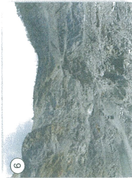
หน้าเหมืองมีลักษณะเป็นขั้นบันได (Bench) มีความสูงหน้าเหมืองไม่เกิน 10 เมตร ความลาดชันรวมไม่เกิน 45 องศา
