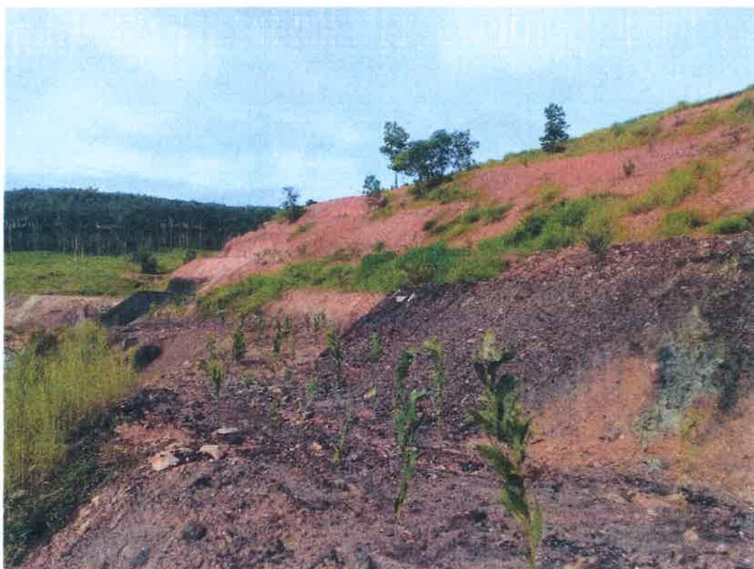
ภาพที่ 5-6 กองเปลือกดินด้านทิศตะวันตก มีการปลูกต้นไม้ พื้นคลุมดินป้องกันการกัดเซาะของน้ำ
