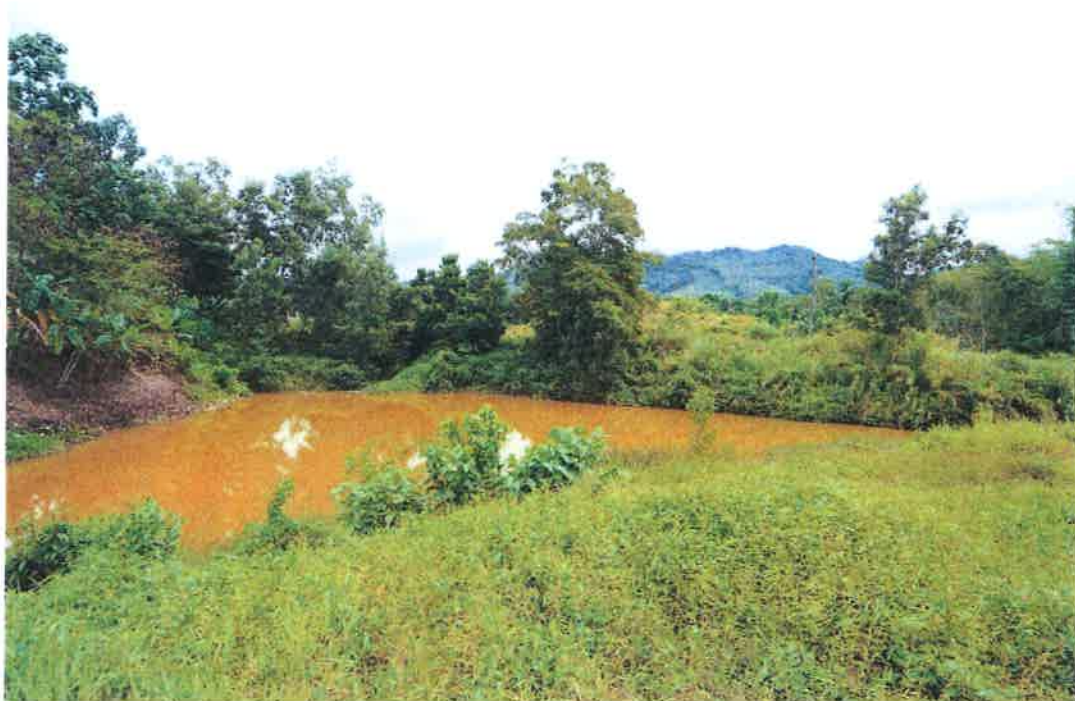
ภาพที่ 11 บ่อดักตะกอน ก่อนปล่อยน้ำออกนอกพื้นที่โครงการ
