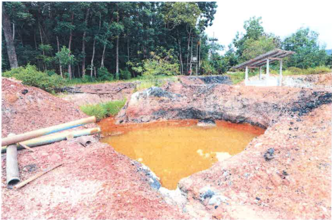
ภาพที่ 10 จุดรับน้ำที่สูบมาจากบ่อเหมือง และจุดทำการโรยปูนขาว กรณีที่ต้องปรับสภาพน้ำ
