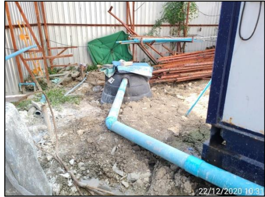
ภาพที่ 15 ถังบำบัดน้ำเสียสำเร็จรูป
