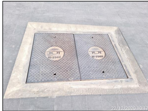
ภาพที่ 45 บ่อพักน้ำสุดท้ายก่อนระบายสู่สาธารณะ
