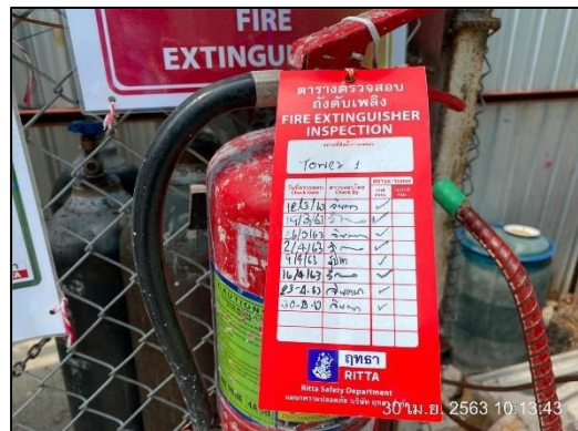
ภาพที่ 29 การตรวจสอบสภาพถังดับเพลิง
