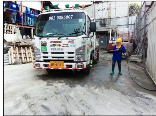
ภาพที่ 32 ฉีดล้างล้อรถบรรทุกแบบ Water Jet
