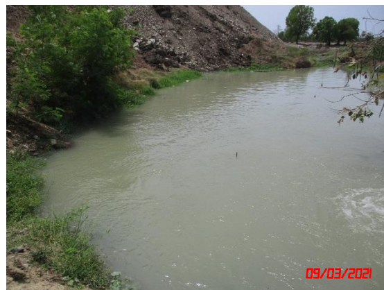
รูปที่ 2-10 ปอดักตะกอน
