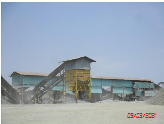
รูปที่ 2-16 อาคารปิดคลุมโรงม่หิน 3 ด้าน
