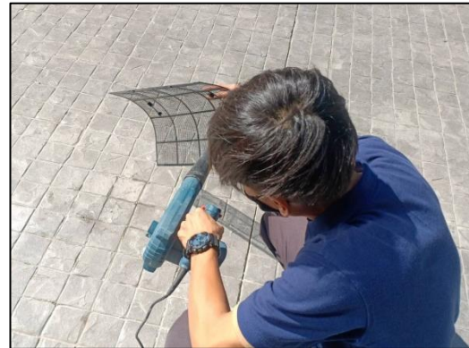
ภาพที่ 25 ทำความสะอาดแผ่นกรองอากาศ และล้างเครื่องปรับอากาศเป็นประจำ
