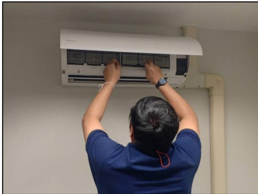
ภาพที่ 25 ทำความสะอาดแผ่นกรองอากาศ และล้างเครื่องปรับอากาศเป็นประจำ
