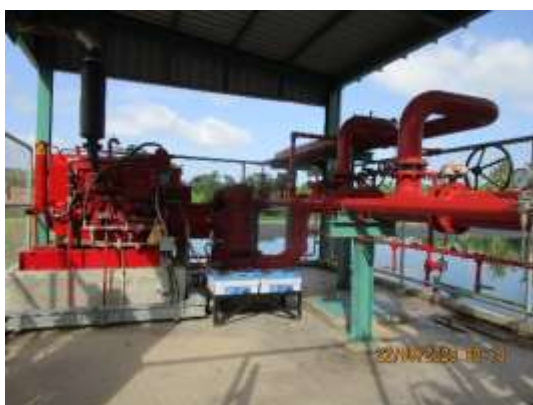
รูปที่ 2-19 ระบบปั๊มดับเพลิง สถานีควบคุมระบบท่อที่ 652
