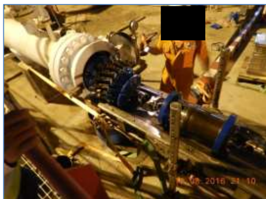
รูปที่ 2-14 การส่ง Intelligent Pig
