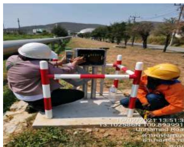
รูปที่ 2-24 การตรวจสอบระบบ AC Mitigation
