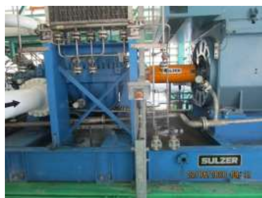
ระบบหยุดปั๊มอัตโนมัติ สถานีควบคุมระบบท่อที่ 652
