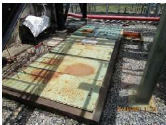
ระบบ OWS ส่วนแยกน้ำมันและส่วนน้ำใส สถานีสูบน้ำจ่ายน้ำมันมาบตาพุด
