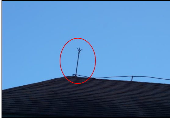
ภาพที่ 1-18 เสาล่อฟ้า
