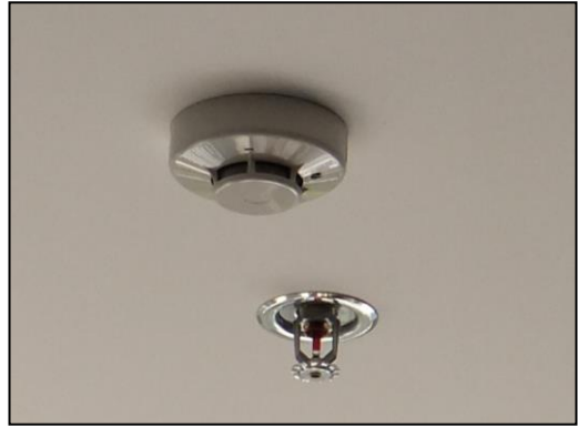
ภาพที่ 2-8 Smoke Detector & Sprinkler
