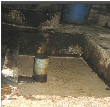
ภาพที่ 2-2 บ่อดักไขมัน , เจ้าหน้าที่ดูและระบบบำบัดน้ำเสียและดักไขมันออกจากบ่อดักไขมันและถูกบำบัดน้ำเสีย
