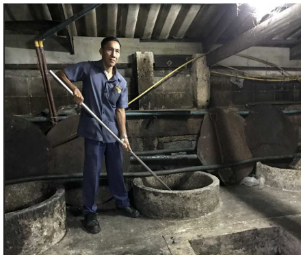
ภาพที่ 2-2 บ่อดักไขมัน , เจ้าหน้าที่ดูและระบบบำบัดน้ำเสียและดักไขมันออกจากบ่อดักไขมันและถูกบำบัดน้ำเสีย
