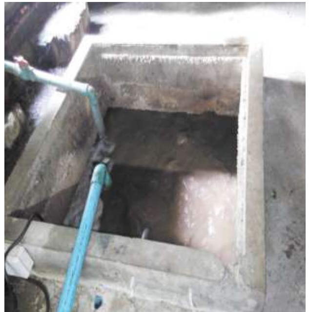
ระบบบำบัดน้ำเสียแบบตะกอนเร่ง (อาคาร E)
