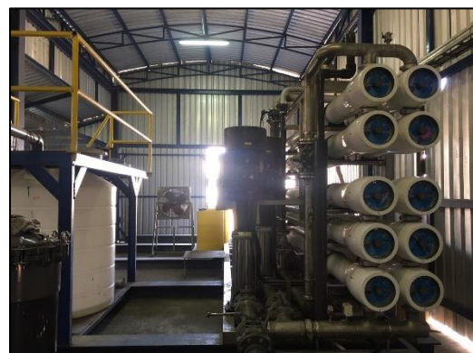
ภาพที่ 19 กระบวนการรีเวอร์สออสโมซิส (Reverse Osmosis ;RO)
