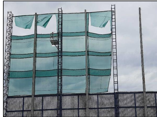
ภาพที่ 7 การติดตั้งโครงสร้างเหล็กคติดาข่าย โดยรอบพื้นที่ลานกองชานอ้อย
