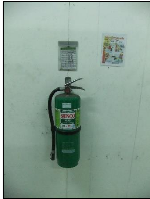
ภาพที่ 29 (ต่อ) การติดตั้งถังดับเพลิงและป้ายแนะนำการใช้ถังดับเพลิง
