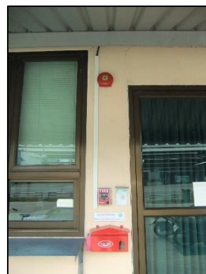
ภาพที่ 30 ระบบสัญญาณเตือนภัย และป้ายบอกทางหนีไฟ กรณีเกิดเหตุเพลิงไหม้
