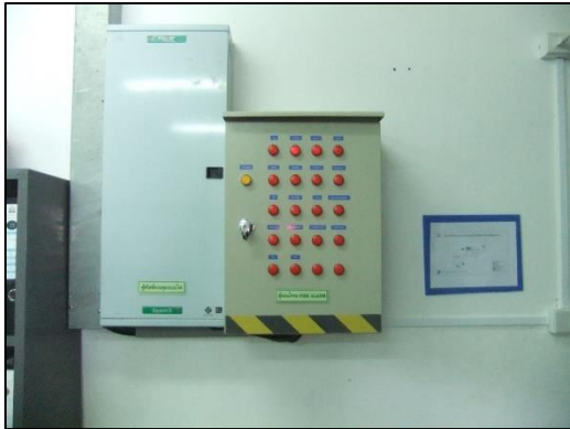
ภาพที่ 30 (ต่อ) ระบบสัญญาณเตือนภัย และป้ายบอกทางหนีไฟ กรณีเกิดเหตุเพลิงไหม้
