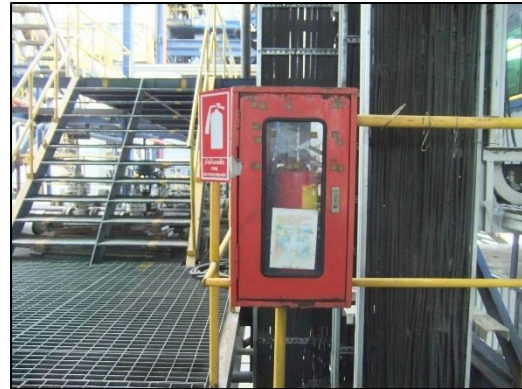
ภาพที่ 29 (ต่อ) การติดตั้งถังดับเพลิงและป้ายแนะนำการใช้ถังดับเพลิง
