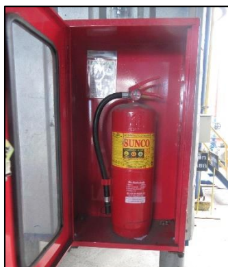
ภาพที่ 29 การติดตั้งถังดับเพลิงและป้ายแนะนำการใช้ถังดับเพลิง
