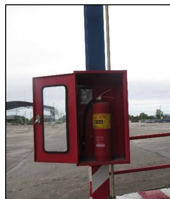
ภาพที่ 29 การติดตั้งถังดับเพลิงและป้ายแนะนำการใช้ถังดับเพลิง
