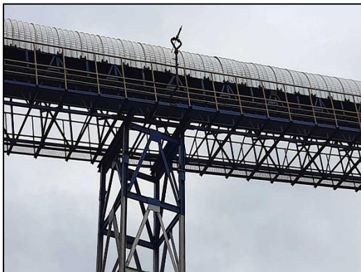
ภาพที่ 2 ระบบสายพานลำเลียงปิดครอบ
