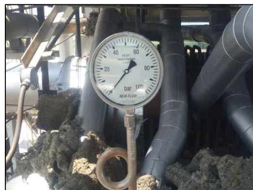
ภาพที่ 43 การติดตั้งอุปกรณ์ตรวจต่างๆ ประจำหน่วยการผลิตหม้อไอน้ำ
