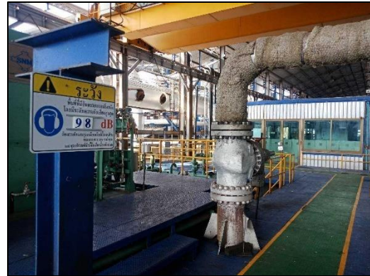
ภาพที่ 14 การติดตั้งอุปกรณ์ลดเสียง (Silencer) บริเวณวาล์วที่มีเสียงดัง
