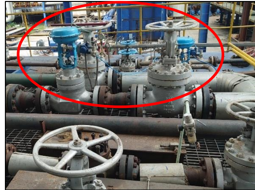
ภาพที่ 45 การติดตั้งชุด Bypass valve
