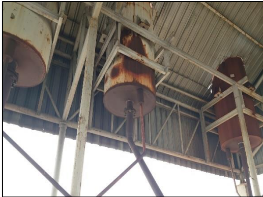
ภาพที่ 14 การติดตั้งอุปกรณ์ลดเสียง (Silencer) บริเวณวาล์วที่มีเสียงดัง
