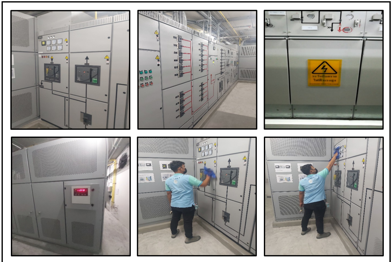
ภาพที่ 11 การตรวจสอบบำรุงรักษาระบบไฟฟ้า
