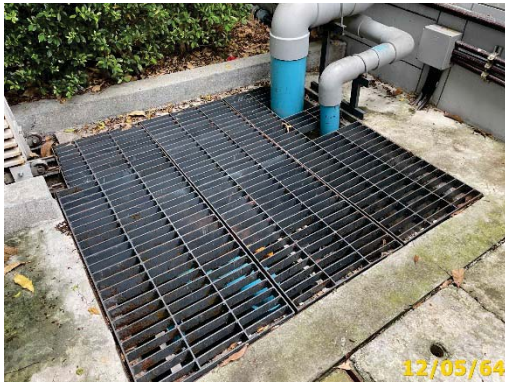
บ่อพักน้ำสุดท้ายก่อนระบายออกนอกโครงการพร้อมตะแกรงดักขยะ
