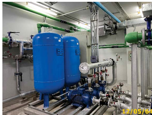
ระบบปั๊มน้ำและจ่ายน้ำใช้
