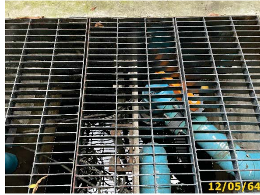
บ่อพักน้ำสุดท้ายก่อนระบายออกนอกโครงการพร้อมตะแกรงดักขยะ
