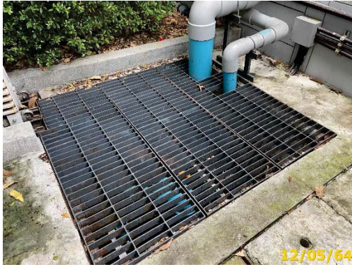
บ่อพักน้ำสุดท้ายก่อนระบายออกนอกโครงการพร้อมตะแกรงดักขยะ
