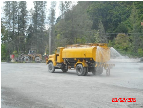
รูปที่ 2-8 การฉีดพรมน้ำบริเวณพื้นที่โดยรอบโครงการ
