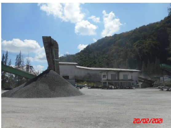
รูปที่ 2-10 อาคารปิดคลุมโรงโม่หิน 3 ด้าน
