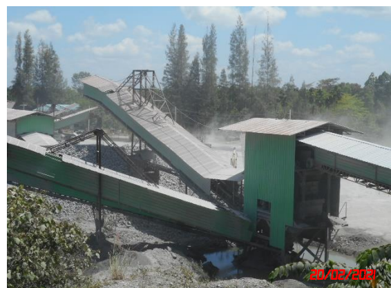
รูปที่ 2-10 อาคารปิดคลุมโรงโม่หิน 3 ด้าน
