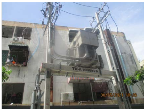
รูปที่ 2-34 หม้อแปลงไฟฟ้าภายในโครงการ
