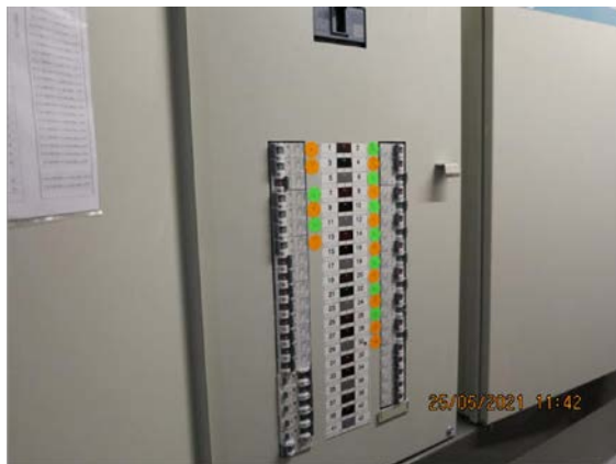
รูปที่ 2-12 สวิตช์แยกระบบบำบัดน้ำเสีย
