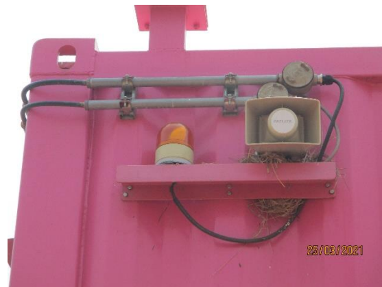
ภาพถ่ายที่ 2.2-16 อุปกรณ์ป้องกันอัคคีภัยและสัญญาณเตือนภัยในพื้นที่ฐานหลุมผลิต
