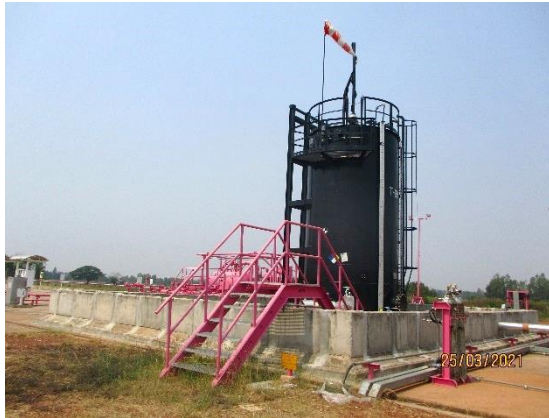
ภาพถ่ายที่ 2.2-13 ถังเก็บน้ำมันดิบมีคั่นคอนกรีตล้อมรอบ
