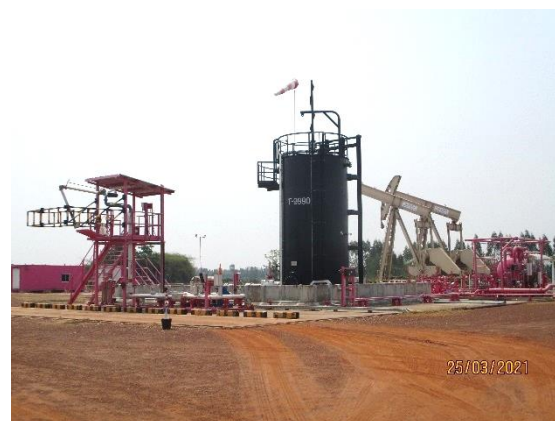
ภาพถ่ายที่ 2.2-5 การจัดวางและติดตั้งอุปกรณ์การผลิตและสารเคมีบนพื้นคอนกรีตที่มีรางระบายน้ำล้อมรอบ
