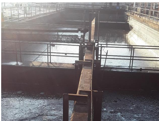
ภาพถ่ายที่ 2.2-7 API Separator ที่สถานีผลิตลานกระบือ
