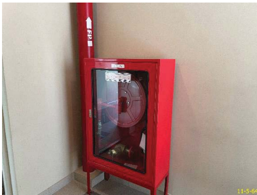
ระบบท่อเย็น และตู้เก็บสายฉีดน้ำดับเพลิง
