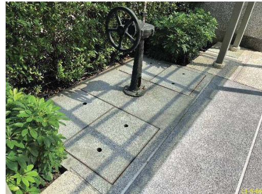
บ่อฟักน้ำสุดท้ายก่อนระบายออกสู่ท่อสาธารณะ
