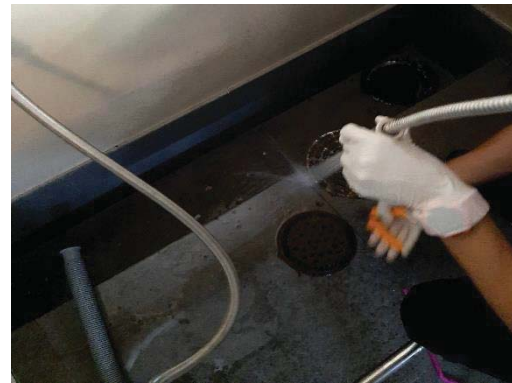
การทำความสะอาดท่อระบายน้ำในอาคาร
