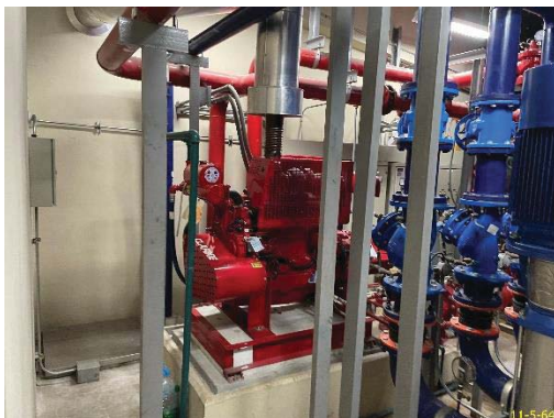
เครื่องสูบน้ำดับเพลิง Low Zone
