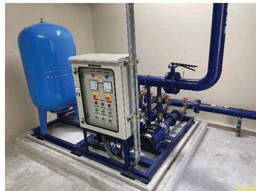
เครื่องสูบน้ำอัดแรงดัน
