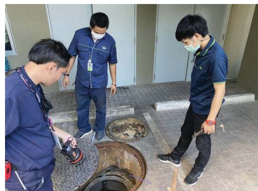
การตรวจสอบปริมาณไขมันในถังดักไขมัน
