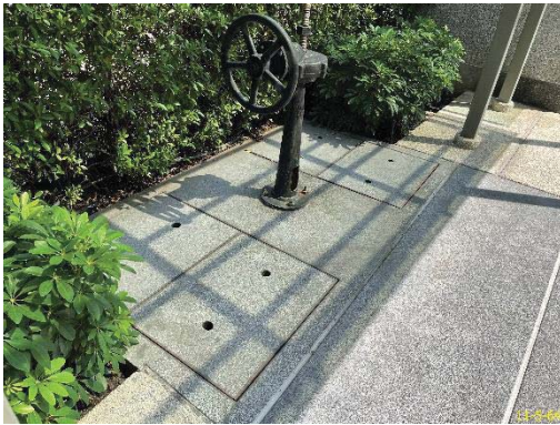
บ่อพักน้ำสุดท้ายก่อนระบายออกสู่ท่อสาธารณะ
