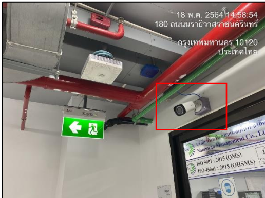
ภาพที่ 41 กล้องวงจรปิด CCTV
