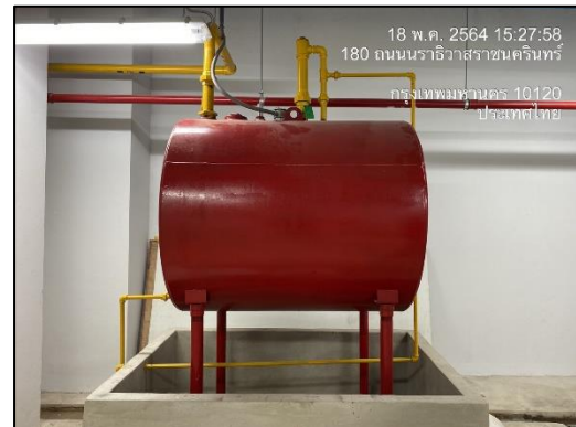
ภาพที่ 46 ถังสำรองน้ำดับเพลิง
