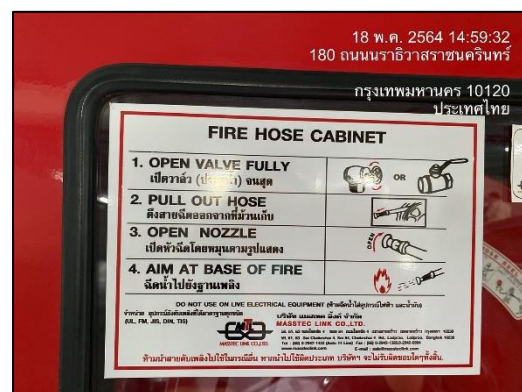
ภาพที่ 47 ถังดับเพลิง/ตู้ดับเพลิง
