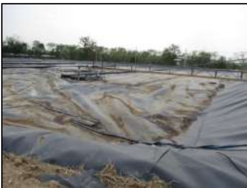
รูปที่ 2-4 พลาสติก HDPE ปิดคลุมบ่อพักน้ำเสียของโครงการ
