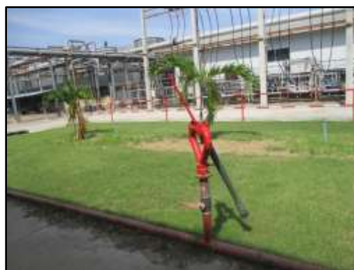
รูปที่ 2-35 ท่อน้ำดับเพลิงโดยรอบพื้นที่ส่วนผลิตและถังเก็บเอทานอล
