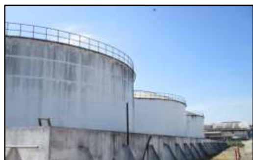
รูปที่ 2-34 คั่นคอนกรีตล้อมรอบถังเก็บเอทานอล
