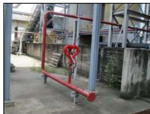
รูปที่ 2-35 ท่อน้ำดับเพลิงโดยรอบพื้นที่ส่วนผลิตและถังเก็บเอทานอล
