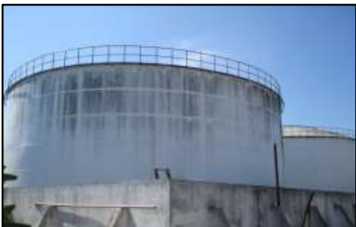
รูปที่ 2-34 คั่นคอนกรีตล้อมรอบถังเก็บเอทานอล
