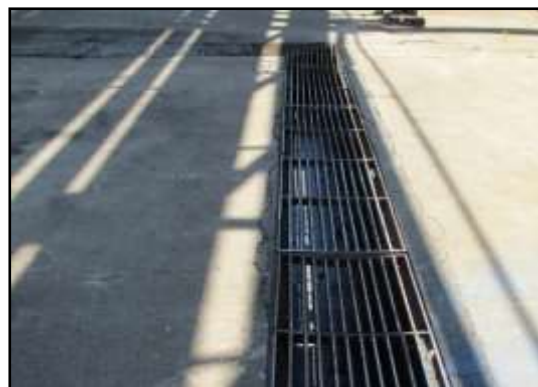
รูปที่ 2-17 รางระบายน้ำรอบพื้นที่โครงการ
