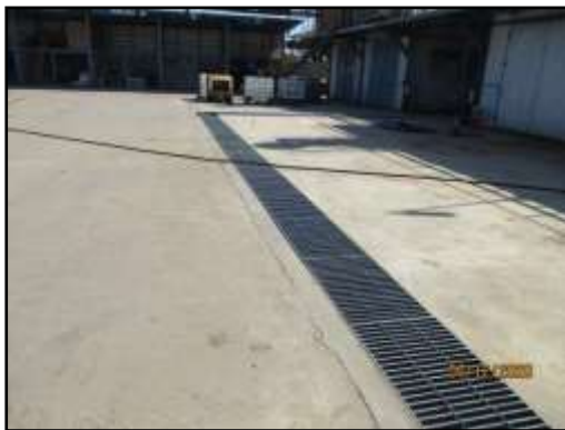
รูปที่ 2-17 รางระบายน้ำรอบพื้นที่โครงการ
