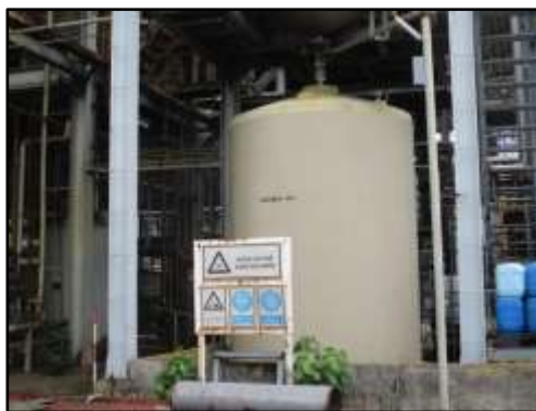
รูปที่ 2-38 ถังเก็บ NaOH
