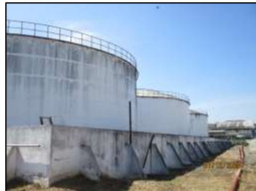
รูปที่ 2-33 คันคอนกรีตล้อมรอบถังเก็บเอทานอล
