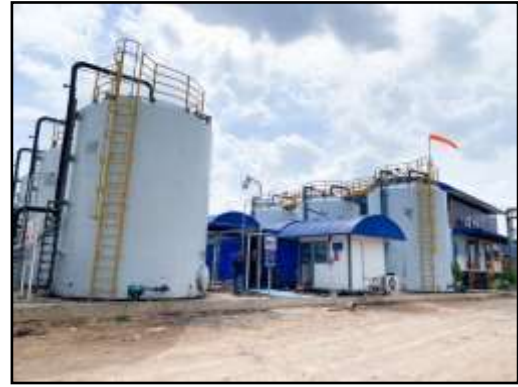
รูปที่ 2-2 ระบบ Bio scrubber ของโครงการ
