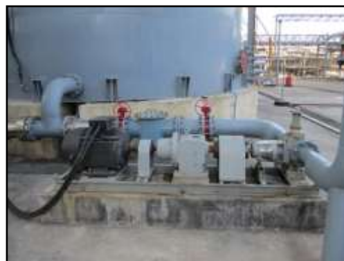
รูปที่ 2-36 ปั๊มสูบกากน้ำตาล
