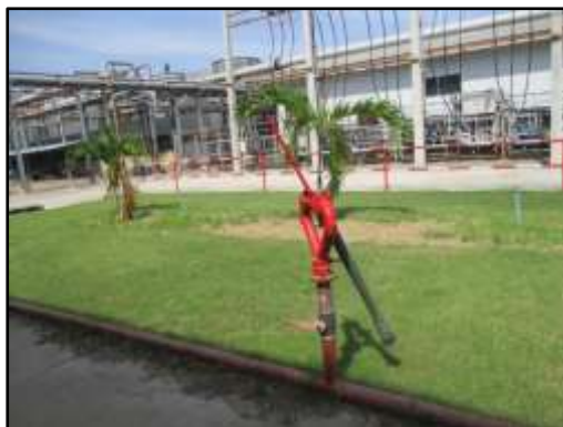
รูปที่ 2-34 ท่อน้ำดับเพลิงโดยรอบพื้นที่ส่วนผลิตและถังเก็บเอทานอล
