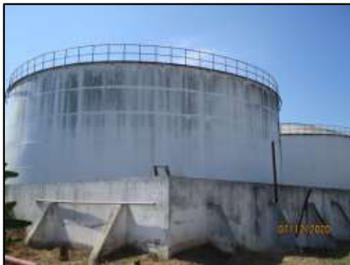
รูปที่ 2-33 คันคอนกรีตล้อมรอบถังเก็บเอทานอล
