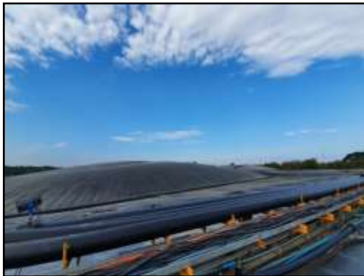
รูปที่ 2-7 ป่อหมักของระบบผลิตก๊าซชีวภาพ ของโครงการ
