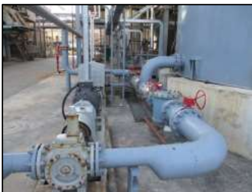
รูปที่ 2-36 ปั๊มสูบกากน้ำตาล
