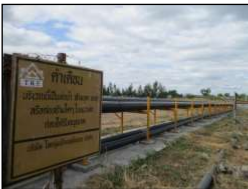
รูปที่ 2-37 ท่อที่ใช้ในการลำเลียงก๊าซชีวภาพของโครงการเป็นท่อ HDPE PE100/PN10
