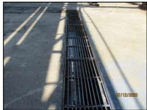
รูปที่ 2-17 รางระบายน้ำรอบพื้นที่โครงการ
