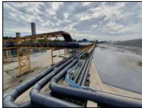
รูปที่ 2-37 ท่อที่ใช้ในการลำเลียงก๊าซชีวภาพของโครงการเป็นท่อ HDPE PE100/PN10
