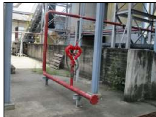
รูปที่ 2-34 ท่อน้ำดับเพลิงโดยรอบพื้นที่ส่วนผลิตและถังเก็บเอทานอล
