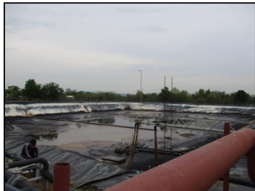
รูปที่ 2-5 บ่อพักน้ำเสีย และบ่อเก็บน้ำกากส่าของโครงการ
