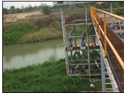
รูปที่ 2-19 สถานีสูบน้ำดิบแม่น้ำป่าสัก
