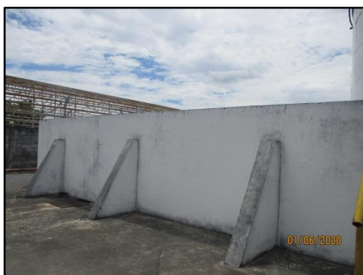
รูปที่ 2-30 ถังคอนกรีตล้อมรอบถังเก็บเอทานอล
