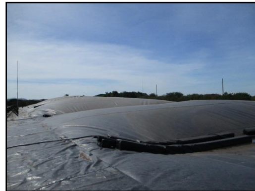
รูปที่ 2-3 ระบบบำบัดน้ำเสียของโครงการ (ระบบผลิตก๊าซชีวภาพ)
