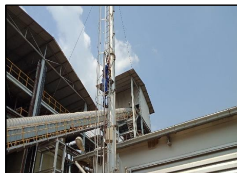
ปล่องระบายของหม้อน้ำ ขนาด 2 ตัน
