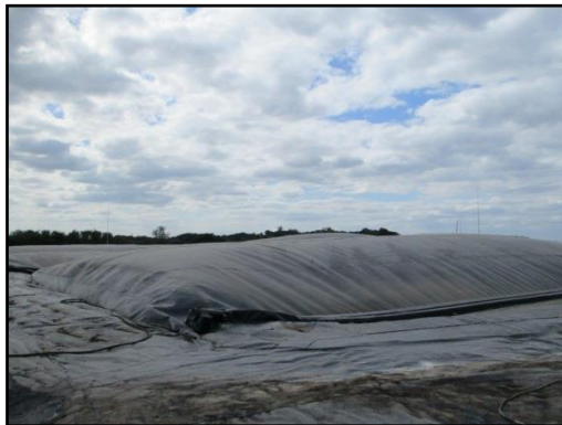
รูปที่ 2-3 ระบบบำบัดน้ำเสียของโครงการ (ระบบผลิตก๊าซชีวภาพ)
