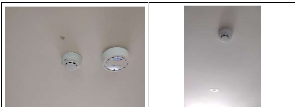
รูปที่ 2-48 แสดงเครื่องตรวจจับควัน (Smoke Detector) และตรวจจับความร้อน (Heat Detector)
