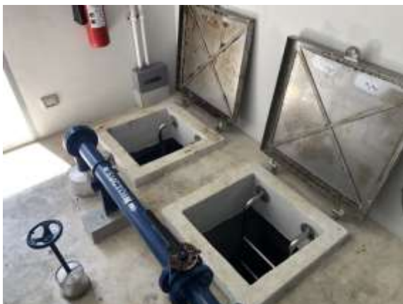
รูปที่ 2-11 แสดงถังเก็บน้ำใต้ดินของโครงการ
