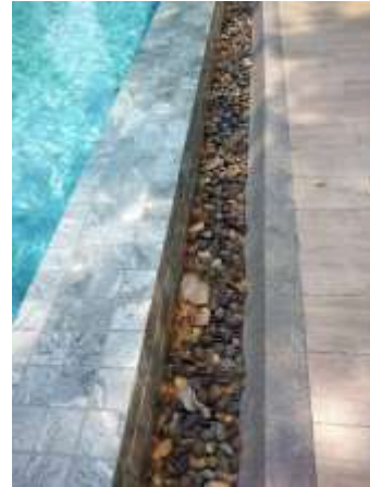
รูปที่ 2-18 แสดงทางเดินรอบสระและรางระบายน้ำรอบสระว่ายน้ำภายในโครงการ
