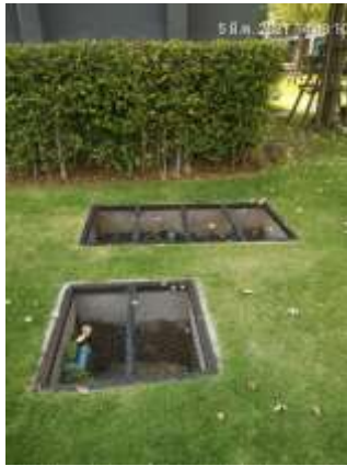
รูปที่ 2-10 แสดงระบบกำจัดก๊าซมีเทนโดยปุ๋ยหมักพร้อมใช้งานฝังลงในหลุมดินซึ่งจะอยู่ภายในพื้นที่สวนหย่อม
