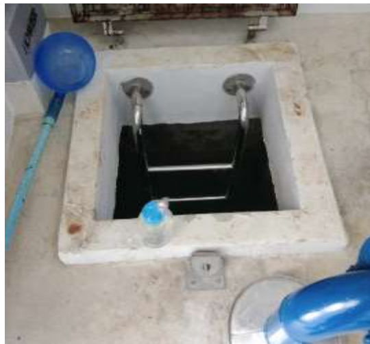
รูปที่ 2-14 แสดงเจ้าหน้าที่ตรวจสอบโครงสร้างถังเก็บน้ำใต้ดินให้มีความมั่นคงแข็งแรง พร้อมทั้งตรวจสอบลักษณะทางกายภาพของน้ำประปา และเก็บตัวอย่างน้ำในถังเก็บน้ำใต้ดิน
