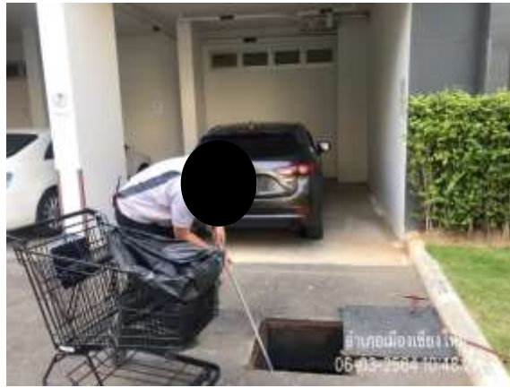
รูปที่ 2-9 แสดงเจ้าหน้าที่ตักไขมันและน้ำมันออกจากถังดักไขมัน
