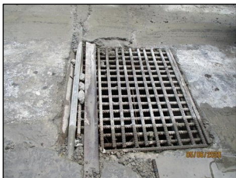
รูปที่ 1-4 ระบบระบายน้ำรอบพื้นที่ก่อสร้าง
