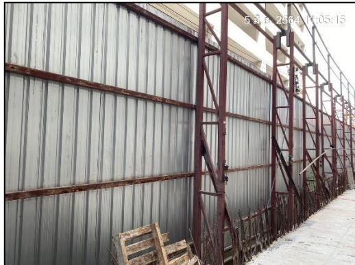
ภาพที่ 1 รั้ว Metal Sheet ความสูง 6 เมตร
