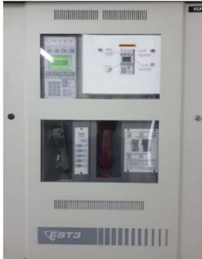
แผงควบคุมสัญญาณแจ้งเหตุเพลิงไหม้
