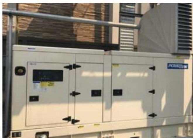
รูปภาพ 1.3.6-3 เครื่องกำเนิดไฟฟ้าสำรอง
