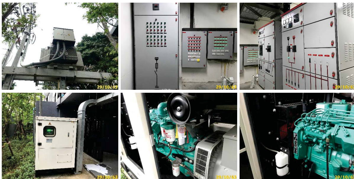
ภาพที่ 1.3.7-1 ระบบไฟฟ้าหลักและระบบไฟฟ้าสำรอง
