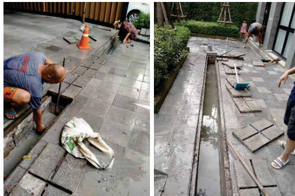
ภาพที่ 2.2-18 ขุดลอกระบบระบายน้ำรอบโครงการ
