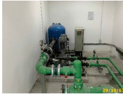
ภาพที่ 1.3.3-2 ถังเก็บสำรองน้ำขึ้นดาดฟ้า
