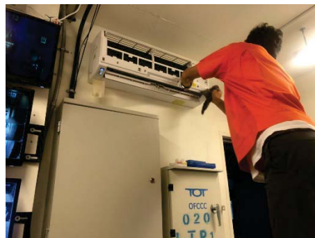
ภาพที่ 2.2-3 ทำความสะอาดเครื่องปรับอากาศในพื้นที่ส่วนกลาง
