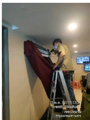
รูปที่ 27 เจ้าหน้าที่ทำความสะอาดเครื่องปรับอากาศ
