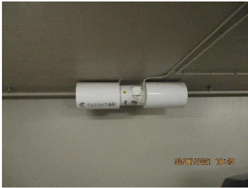
รูปที่ 1 ระบบระบายอากาศบริเวณพื้นที่จอดรถชั้นใต้ดิน
