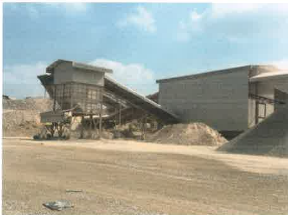
รูปที่ 9 การปิดคลุมอาคารโรงโม่หิน ชุด Secondary Crusher
