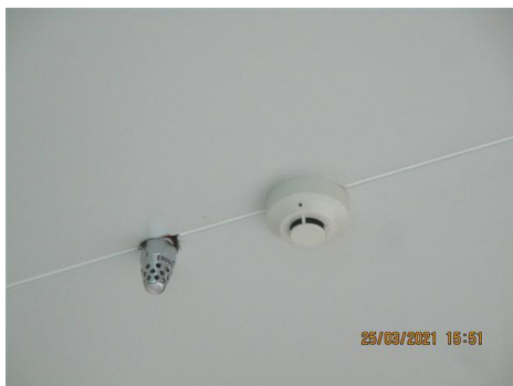
ภาพที่ 2-36 ระบบตรวจสอบ ตรวจจับ และสัญญาณเตือนภัยแบบอัตโนมัติ
