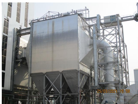
ภาพที่ 2-4 อุปกรณ์ดักจับฝุ่นแบบไฟฟ้าสถิต (ESP)
