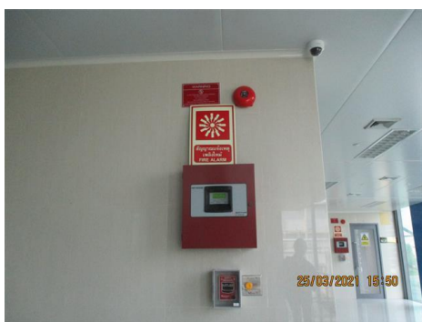
ภาพที่ 2-36 (ต่อ) ระบบตรวจสอบ ตรวจจับ และสัญญาณเตือนภัยแบบอัตโนมัติ
