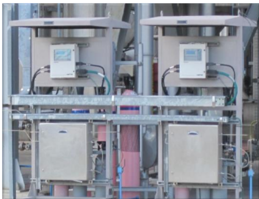
รูปที่ 2-4 การติดตั้งระบบตรวจวัดคุณภาพอากาศแบบต่อเนื่อง (CEMs) ที่ปล่อง Pacol และปล่อง Hot Oil
