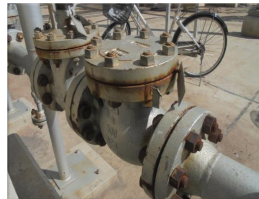
รูปที่ 2-45 Check Valve
