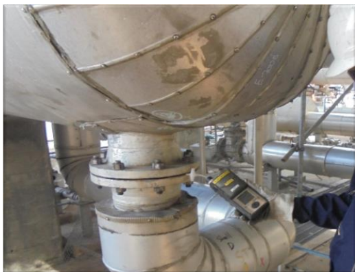
รูปที่ 2-32 การทดสอบการรั่วซึม Leak Test บริเวณข้อต่อ และหน้าแปลนภายในกระบวนการผลิต
