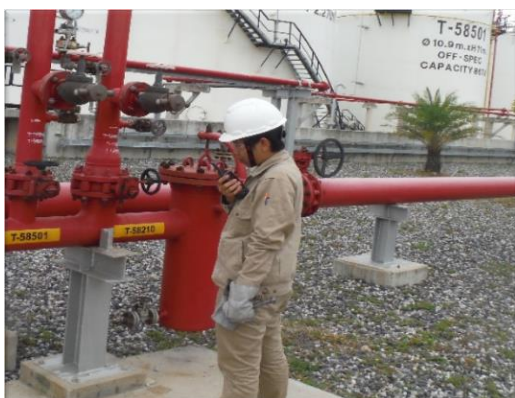
รูปที่ 2-46 การตรวจสอบสภาพท่อขนส่งโดย Inspector ด้วยวิธี Visual Check
