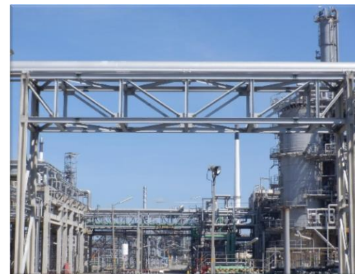
รูปที่ 2-43 การวางท่อบน Pipe Rack หรือ Pipe Bridge ในลักษณะที่ปลอดภัย
