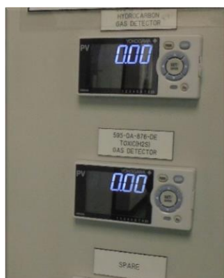
รูปที่ 2-34 Control Panel ที่มีวงจรตรวจจับก๊าซรั่ว ที่สามารถส่งข้อมูลไปยังจอภาพ โทรทัศน์วงจรปิดป้อมยาม ห้องควบคุม และห้อง Safety
