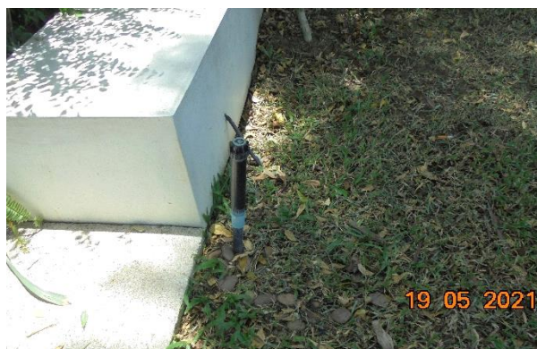
รูปที่ 2-6 น้ำที่ผ่านการบำบัดนำมาใช้รดน้ำต้นไม้บนพื้นที่สีเขียวโดยใช้ระบบสปริงเกอร์
