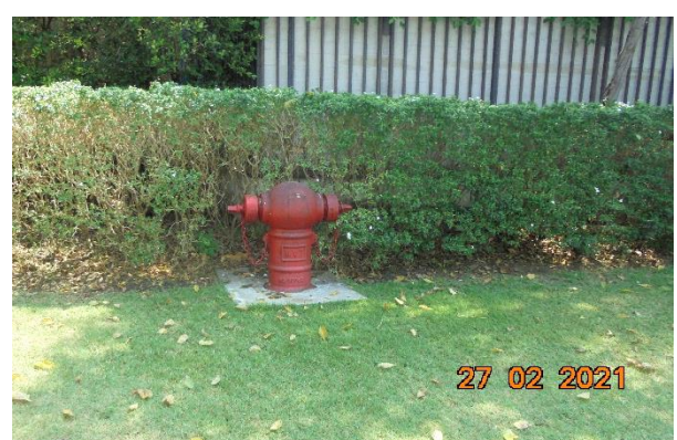
รูปที่ 2-15 หัวจ่ายน้ำดับเพลิงและอุปกรณ์ป้องกันอัคคีภัยเบื้องต้น
