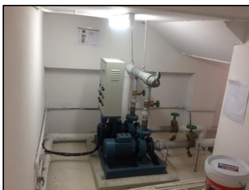
รูปที่ 1-5 ปั๊มถังเก็บน้ำชั้นใต้ดิน
