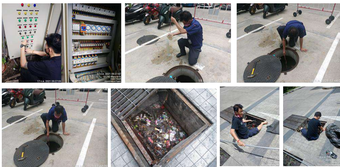
ภาพที่ 2-12 ภาพการดูแลตรวจสอบระบบบำบัดน้ำเสีย และระบบระบายน้ำของโครงการ
