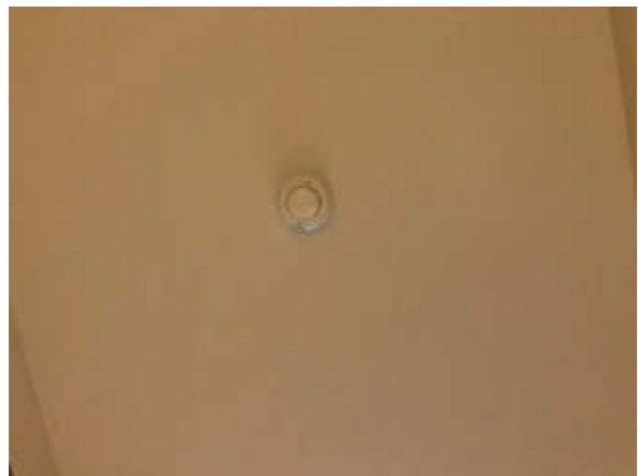
รูปที่ 2-19 อุปกรณ์ตรวจจับควัน
