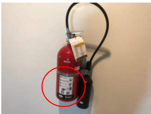
รูปที่ 2-2 ถังดับเพลิงชนิดมือถือและคำแนะนำการใช้
