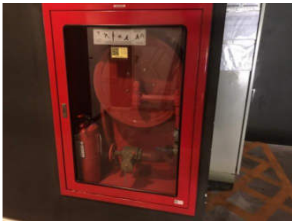
รูปที่ 2-18 ตู้เก็บสายฉีดน้ำดับเพลิง
