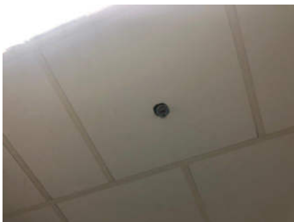
รูปที่ 2-20 หัวกระจายน้ำดับเพลิง
