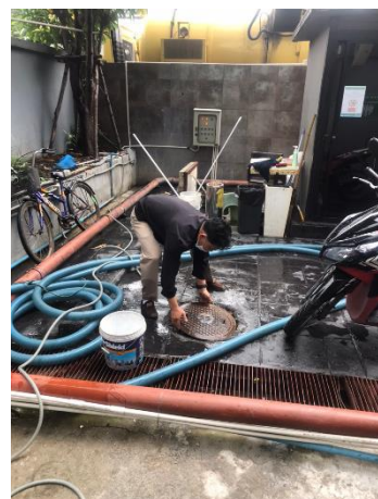
ภาพที่ 7 เจ้าหน้าที่ดูแลระบบบำบัดน้ำเสีย การตัดไฟมัน และรดสูบลูกสูบเข้าสู่อ่างเก็บน้ำส่วนเกิน
