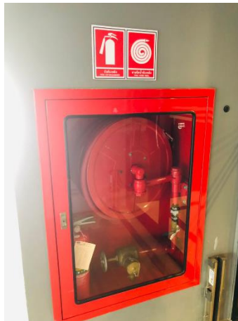
ตู้ FHC และถังดับเพลิงแบบมือถือพร้อมวิธีการใช้งาน
