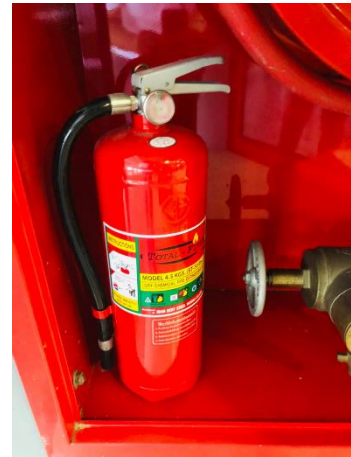
ตู้ FHC และถังดับเพลิงแบบมือถือพร้อมวิธีการใช้งาน
