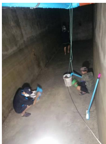
ภาพที่ 13 การทำความสะอาดถังเก็บน้ำใต้ดินประจำปี
