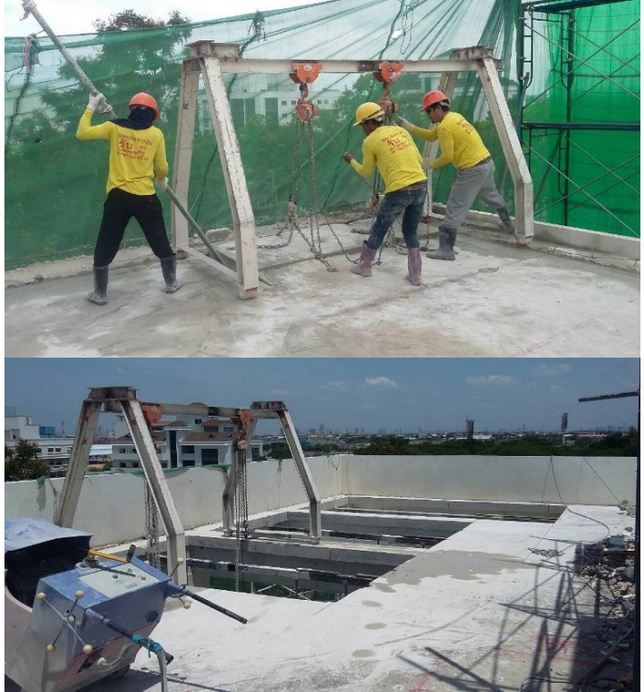
รูปที่ 4.1.4-1 ตัวอย่างวิธีการตัดคอนกรีต ด้วย
