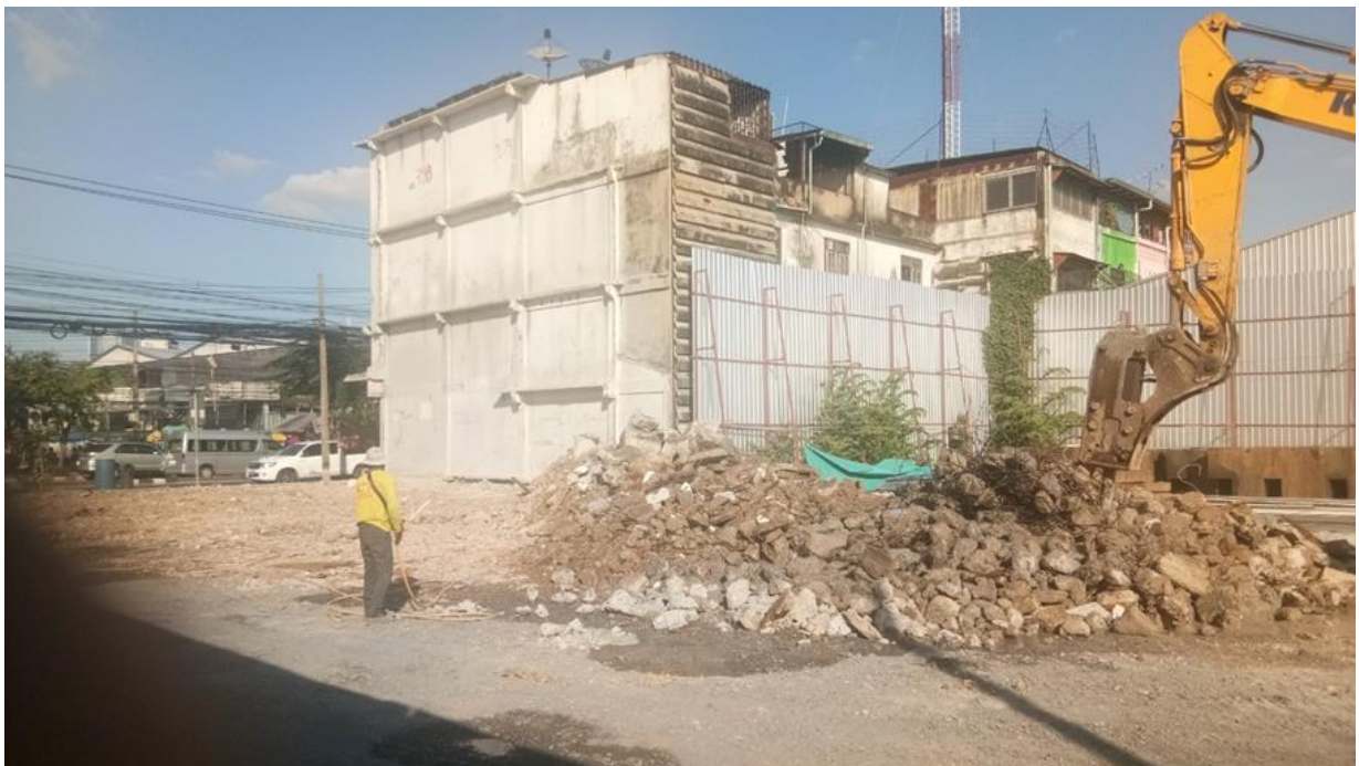
รูปที่ 4.1.4-2 แสดงตัวอย่างผนังของอาคาร หลังการรื้อถอนแนวอาคารที่มีผนังร่วมกัน
