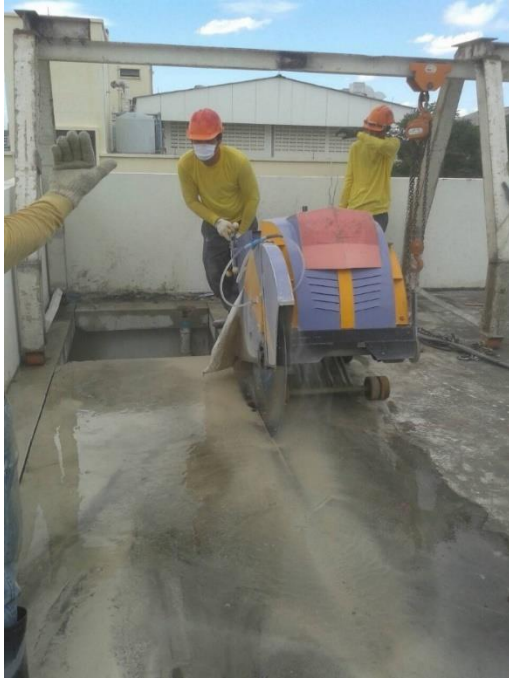
รูปที่ 4.1.4-1 ตัวอย่างวิธีการตัดคอนกรีต ด้วย
