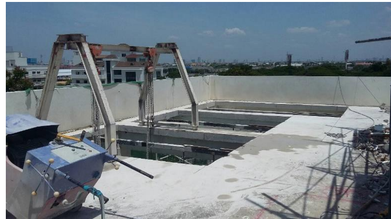
รูปที่ 2 ตัวอย่างวิธีการตัดคอนกรีต ด้วยวิธี Saw Cut
