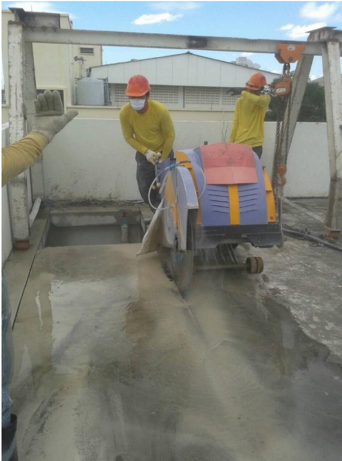
รูปที่ 2 ตัวอย่างวิธีการตัดคอนกรีต ด้วยวิธี Saw Cut
