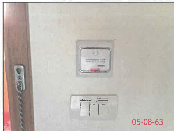
ระบบคีย์การ์ดควบคุมการเปิด-ปิด ไฟ
