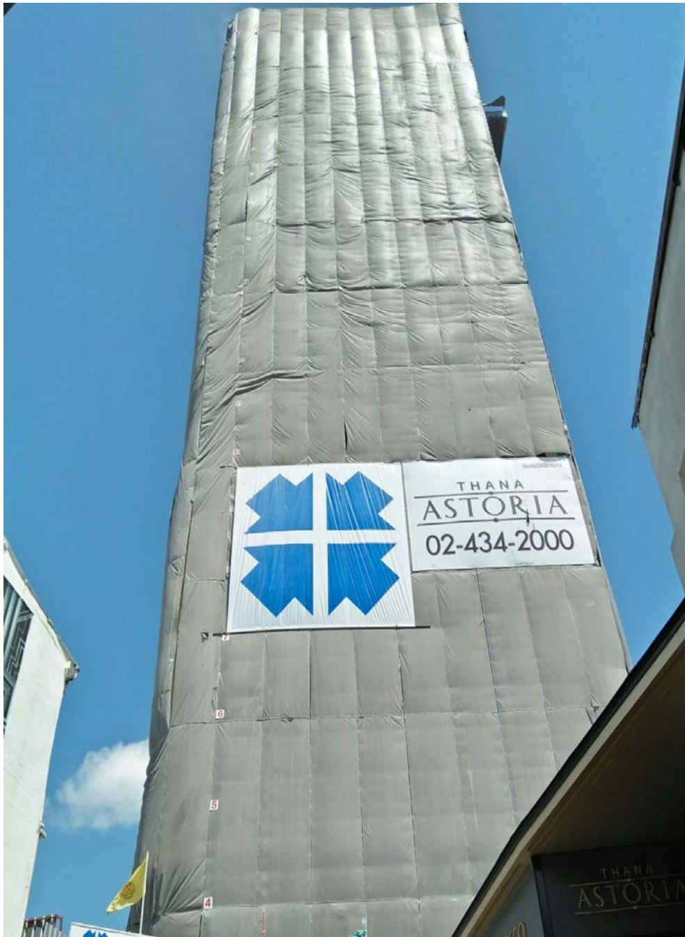
รูปตัวอย่างการห่อหุ้มตัวอาคารด้วยผ้าใบกันฝุ่น โครงการที่แล้วของ บริษัท ธนาแลนด์ จำกัด
