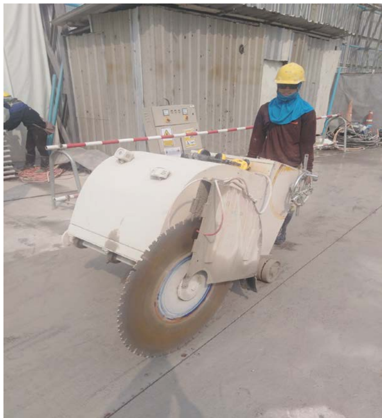
ภาพแสดงวิธีการตัดพื้นอาคาร และ เสา
