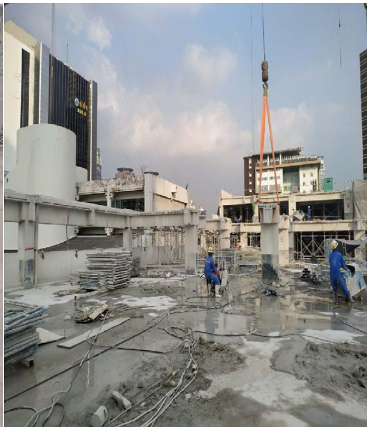
ภาพแสดงวิธีการตัดพื้นอาคาร และ เสา
