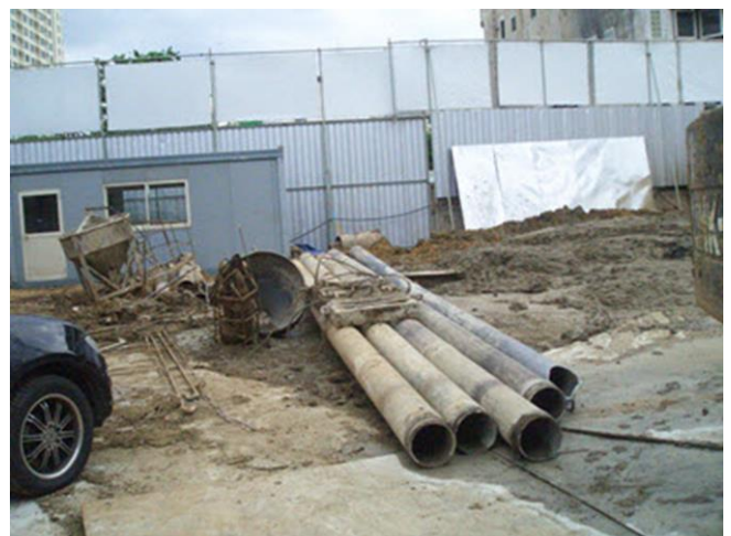
ท่อเทคอนกรีตใต้น้ำ (Tremie pipe)
