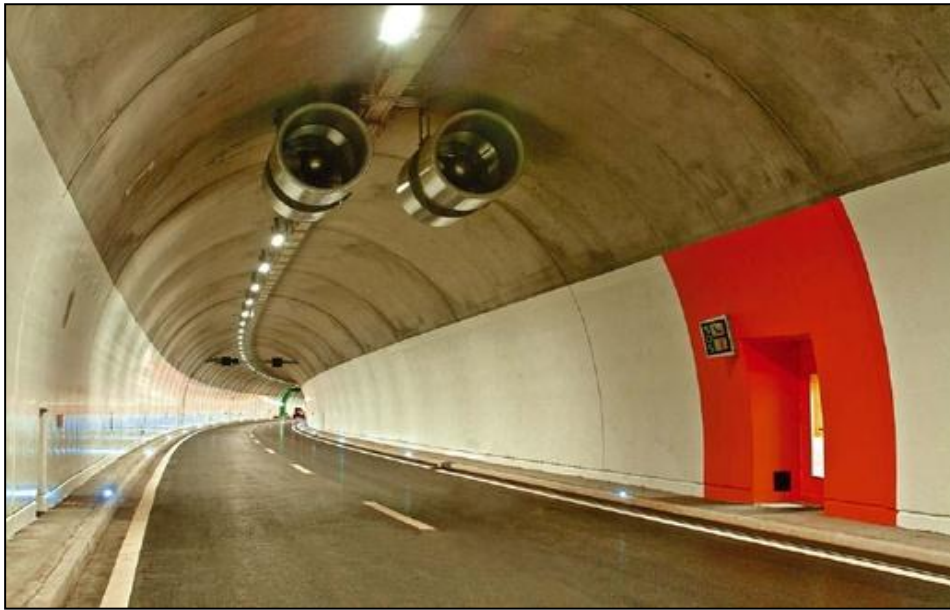
ภาพที่ 2.3.5-1 ตัวอย่างระบบระบายอากาศแบบตามยาวของอุโมงค์ โดยใช้ Jet Fan
