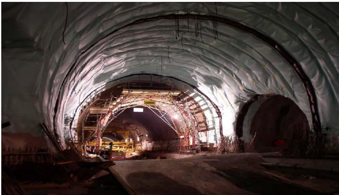
ภาพที่ 2.2.2-5 การก่อสร้างการขุดส่วนล่างของอุโมงค์
