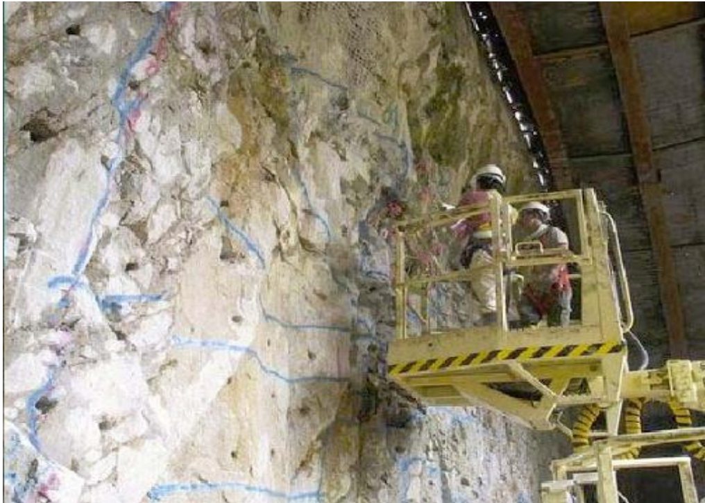
ภาพที่ 2.2.2-1 ตัวอย่างการวางตำแหน่งของรูเจาะที่จะฝังดินระเบิด
