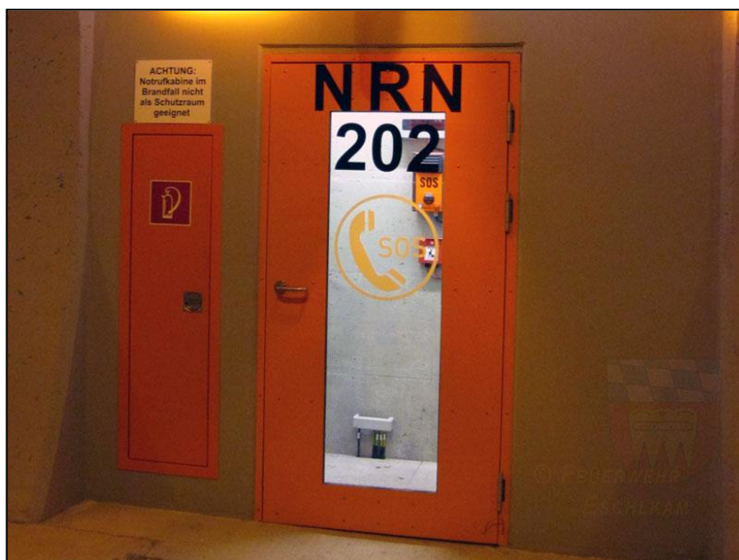
ภาพที่ 2.3.7-1 ตัวอย่างโทรศัพท์ฉุกเฉินในอุโมงค์
