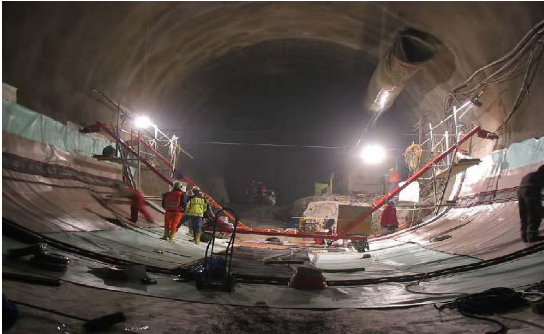
ภาพที่ 2.2.2-5 การก่อสร้างการขุดส่วนล่างของอุโมงค์
