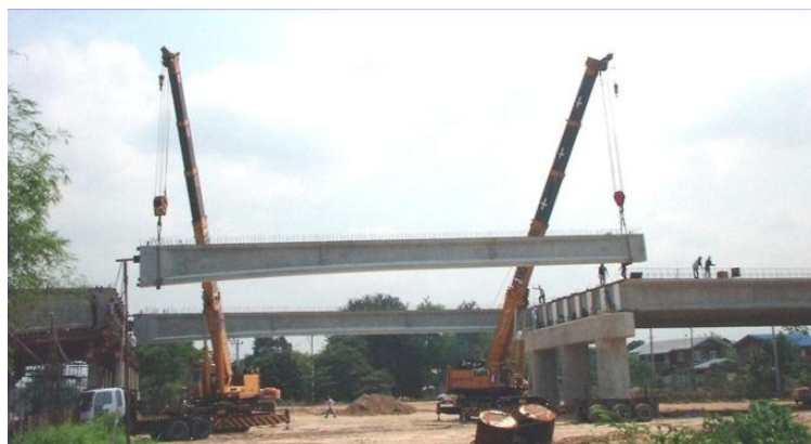
ภาพที่ 2.2.1-1 ก่อสร้างแบบรถยก(Mobile Cranes)
