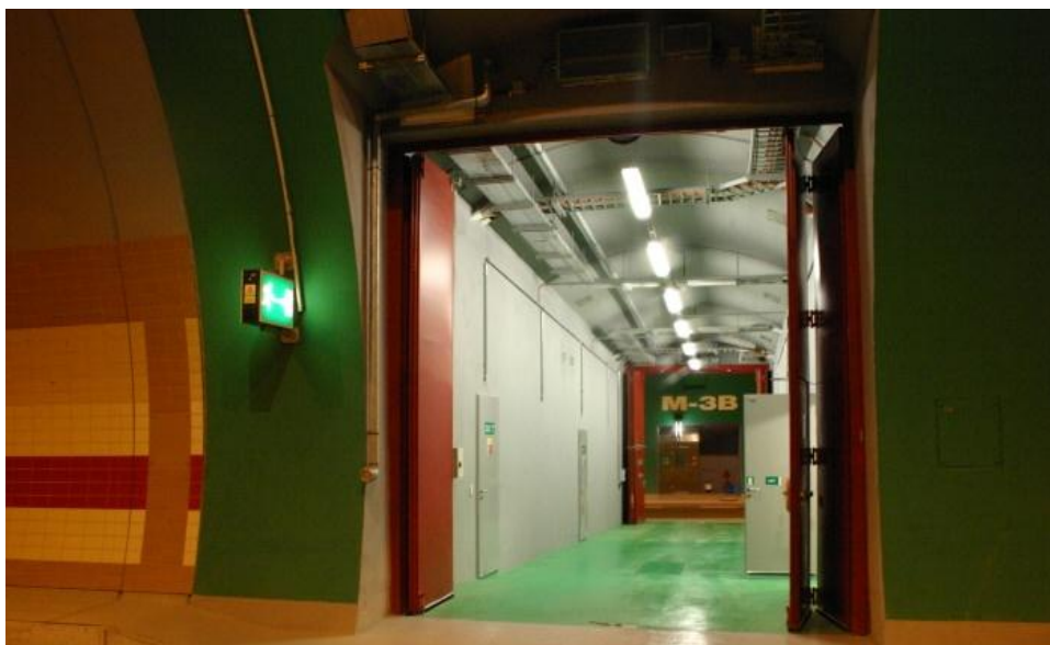
ภาพที่ 2.3.7-3 ตัวอย่างอุโมงค์ฉุกเฉิน (Cross Passage)
