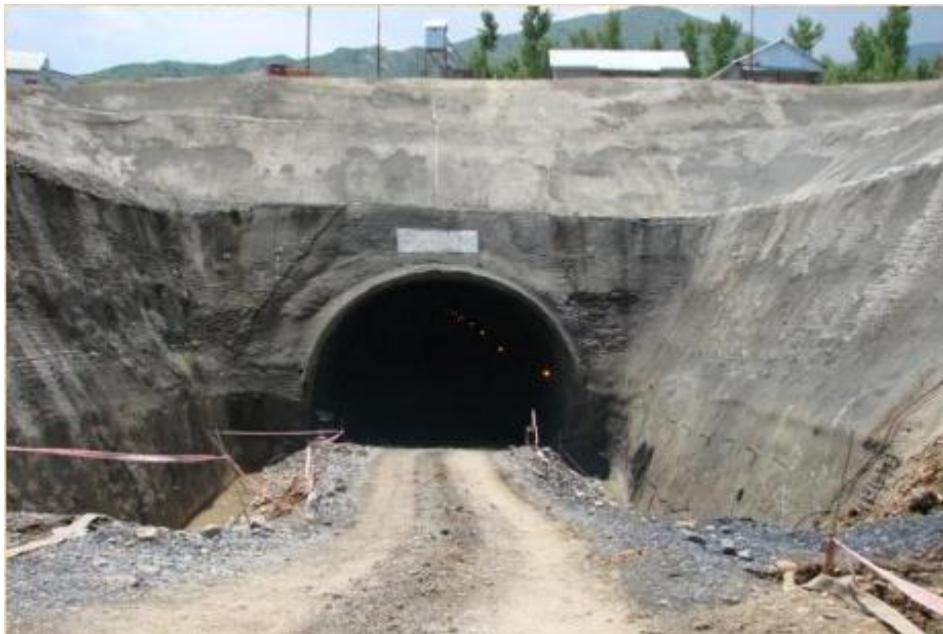
รูปที่ 2.3.10-2 การทำ Shotcrete บริเวณปากอุโมงค์
