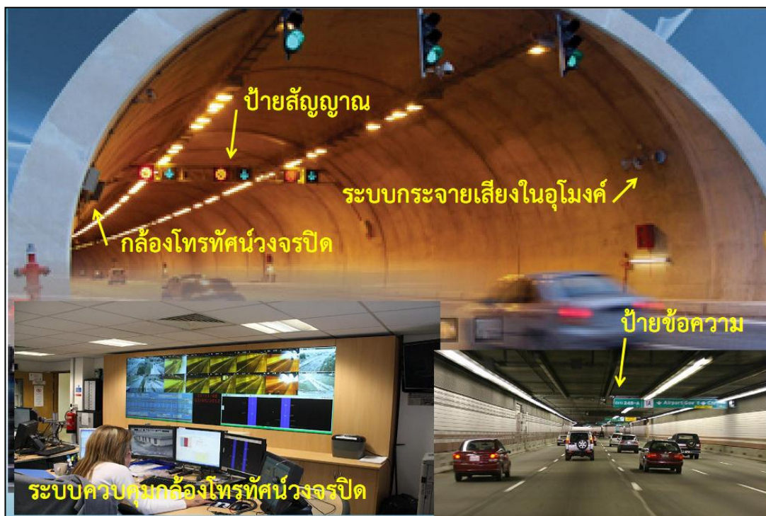
ภาพที่ 2.3.6-1 ตัวอย่างอุปกรณ์ฉุกเฉินต่างๆ ในอุโมงค์
