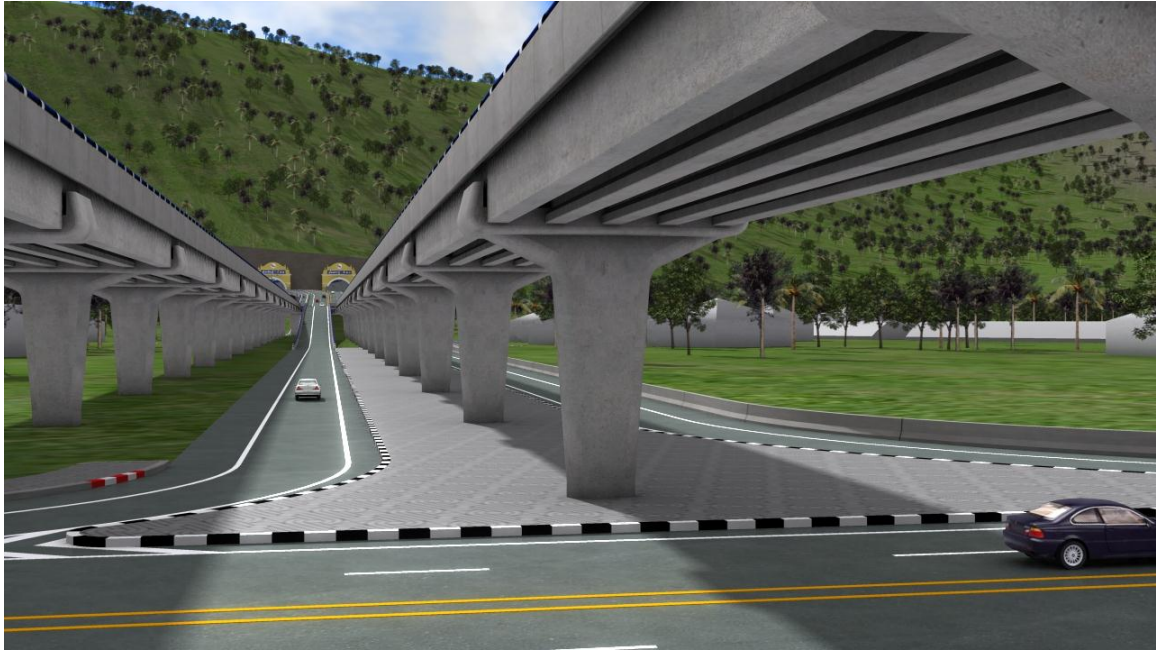
รูปที่ 2.2.1-7 รูปตัดทั่วไปของโครงสร้างสะพานยกระดับ (โครงสร้างแบบคานคอนกรีตรูปตัวไอ (I-Girder))
