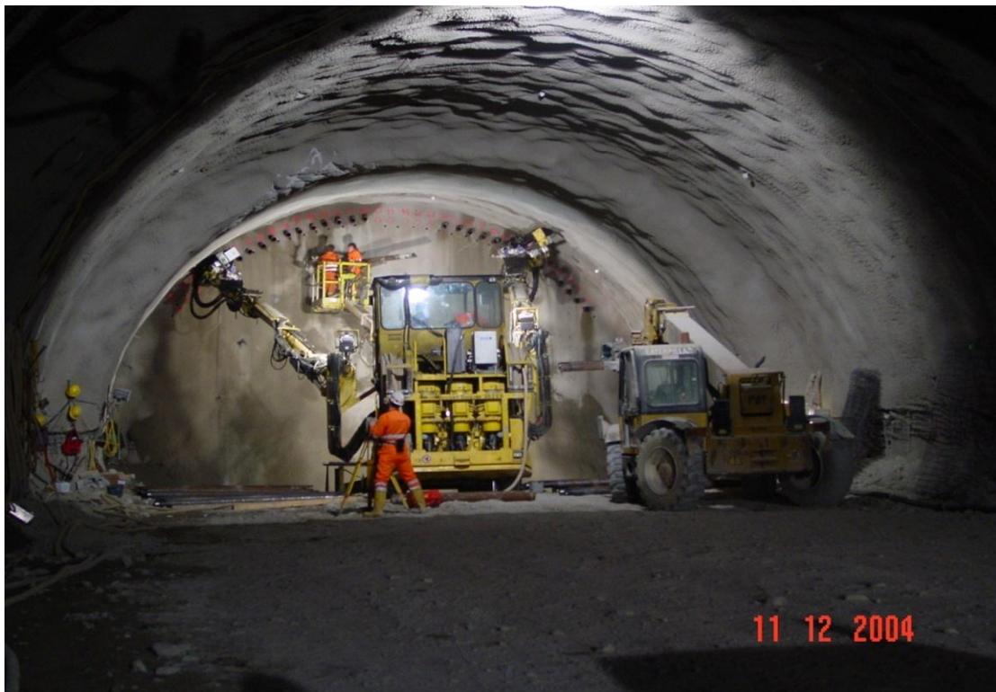
ภาพที่ 2.2.2-4 การก่อสร้างการขุดส่วนบนของอุโมงค์
