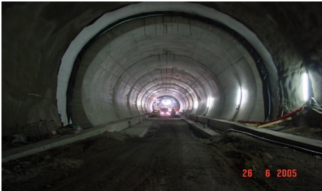
ภาพที่ 2.2.2-7 ตัวอย่างการติดตั้งผนังอุโมงค์
