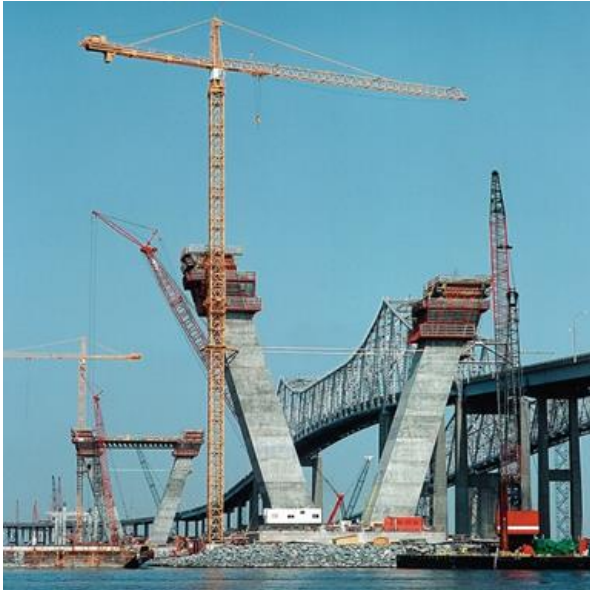
รูปที่ 2.10-4 ตัวอย่างระบบนั่งร้านเคลื่อนที่ได้
