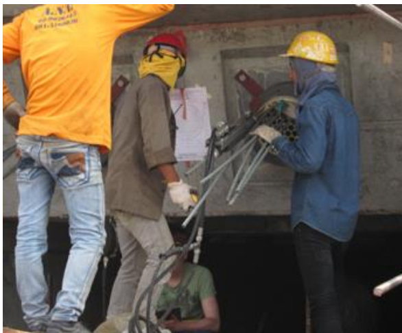
รูปที่ 2.10-1 การติดตั้งเคเบิลด้วยการดึงลวดตีเกลียวทีละเส้นด้วยเครื่องมือที่มีขนาดเล็กและการเชื่อมต่อ HDPE ของเคเบิล
