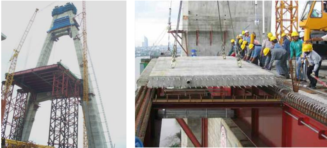
รูปที่ 2.10-6 ตัวอย่างการติดตั้งคานสะพานคอมโพสิตในช่วงแรกโดยใช้นั่งร้านช่วยและการติดตั้งแผ่นพื้นคอนกรีตหล่อสำเร็จ
