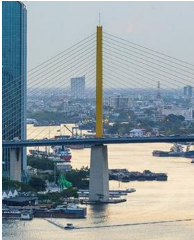
รูปที่ 2.10-3 ฐานรากเสาสูงสะพานพระราม 9 ยื่นล้ำเข้าไปในแม่น้ำเจ้าพระยา
