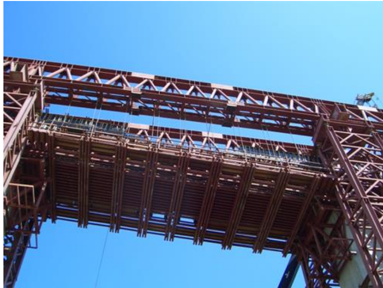
รูปที่ 2.11-1 การตั้งนั่งร้านรับแบบหล่อ Portal Frame
