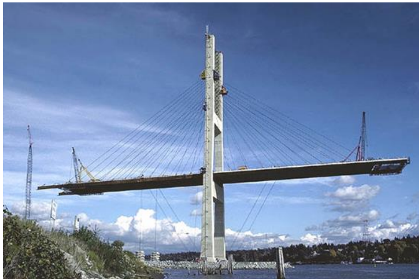
รูปที่ 2.10-5 การก่อสร้างแบบ Balanced Cantilever ในสะพานชิง
