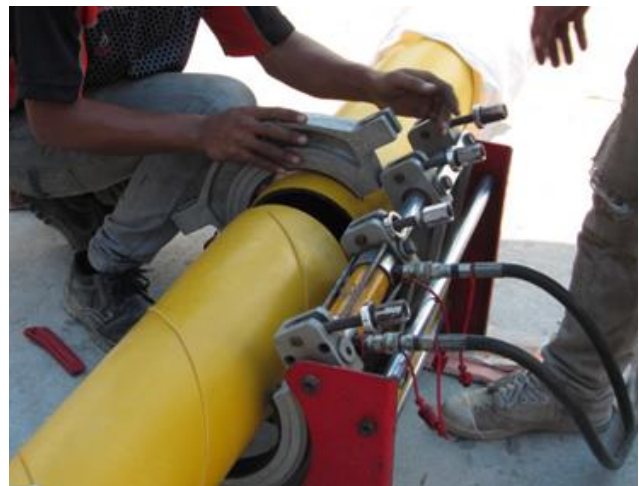
รูปที่ 2.10-1 การติดตั้งเคเบิลด้วยการดึงลวดตีเกลียวทีละเส้นด้วยเครื่องมือที่มีขนาดเล็กและการเชื่อมต่อ HDPE ของเคเบิล
