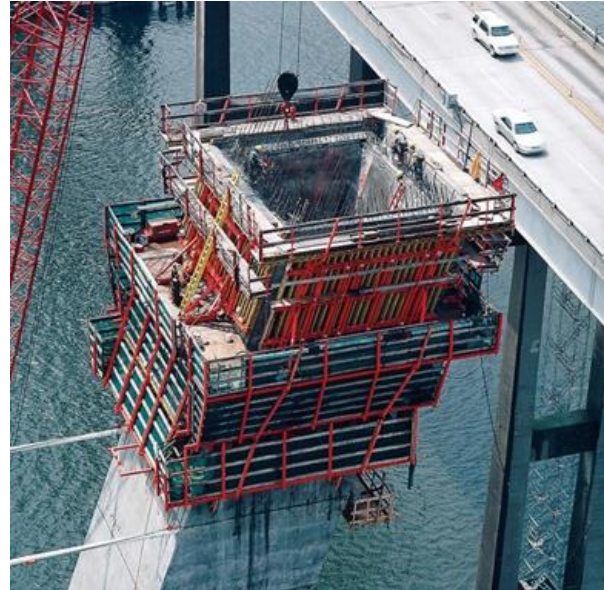
รูปที่ 2.10-4 ตัวอย่างระบบนั่งร้านเคลื่อนที่ได้
