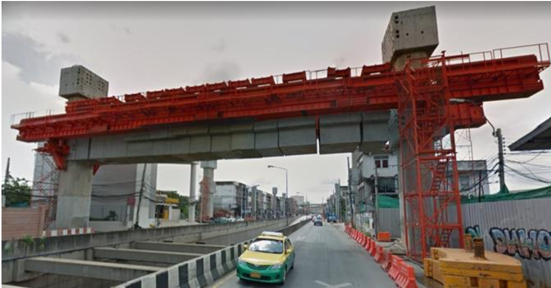
รูปที่ 2.11-3 รูปแบบคานขวางแบบ Segmental
