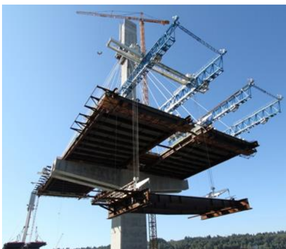
รูปที่ 2.10-7 ตัวอย่างของเครื่องจักรสำหรับยกชิ้นส่วนกำลังยกโครงสร้างคานเหล็กขึ้นติดตั้ง และเรือทอจแบน
