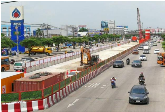
ตัวอย่างการจัดจราจรรองรับพื้นที่ก่อสร้าง ในแนวเกาะกลางถนนอย่างต่อเนื่อง
