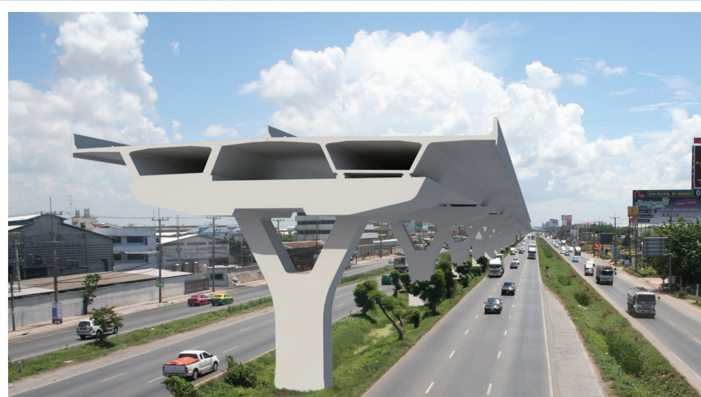
▲ รูปแบบโครงสร้างตามแนวเกาะกลางถนนพระรามที่ 2 ช่วงวงแหวนรอบนอกฯ ถึงดาวคะนอง
