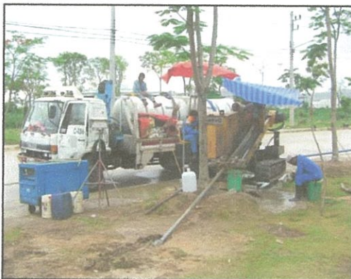
ขั้นที่ 3 : ขั้นตอนการเจาะลอด
