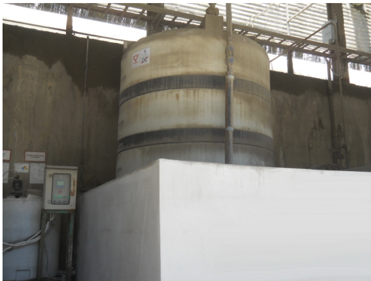
รูปที่ 1 ลักษณะของคั่นกัน (Bund) ที่ใช้ในการรองรับสาร NaOCl ในกรณีที่เกิดการรั่วไหล
