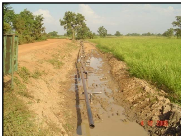
4) ท่อจะถูกนำมาจัดเรียงบนฐานวางท่อเพื่อการเชื่อมประกอบ
