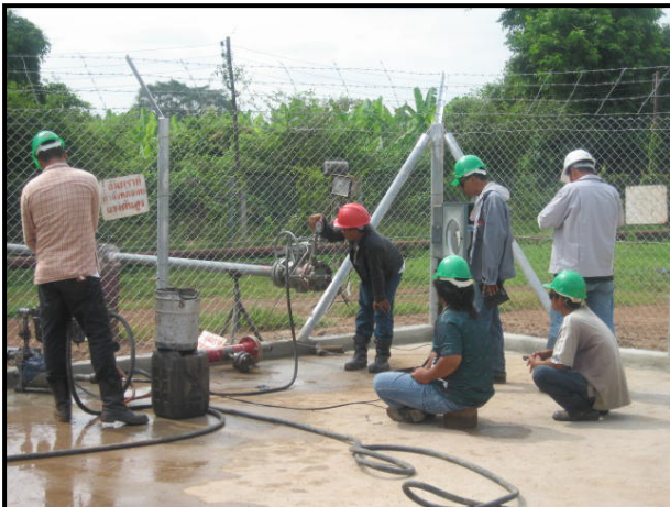
7) การทดสอบการรั่วไหลด้วยวิธีสถิตยศาสตร์ (Hydrostatic test)
