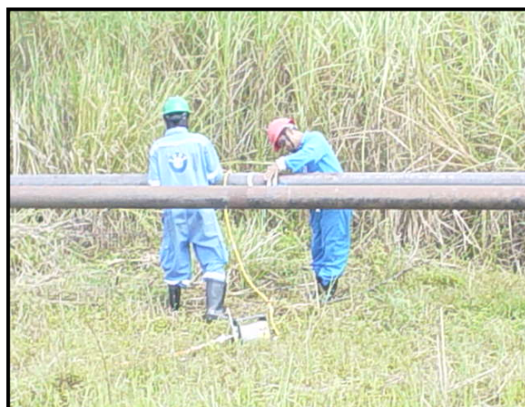
6) การตรวจสอบรอยเชื่อมด้วยวิธี NDT
