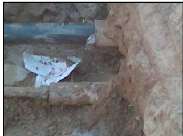
10) ท่อน้ำมันและท่อก๊าซจะได้รับการหุ้มด้วยฉนวนสวมอยู่ในปลอกท่อ(Pipe sleeve)
