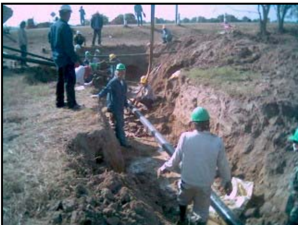
9) การขุดเปิดร่องเพื่อดันท่อลอดผ่านถนน (Pipe jacking)
