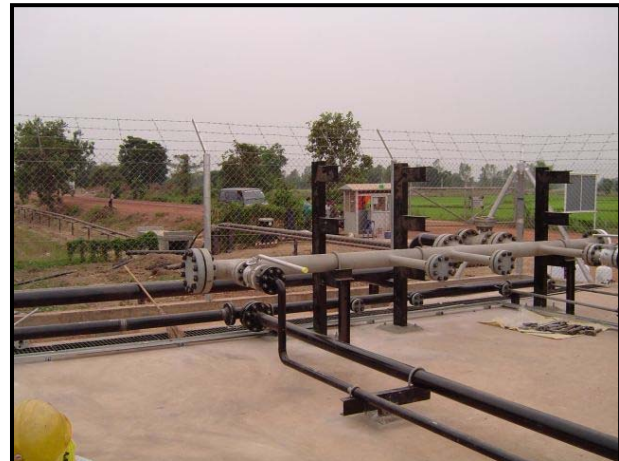
8) ท่อจะได้รับการ Tie-in เข้ากับ Mainfold ในฐานผลิต
