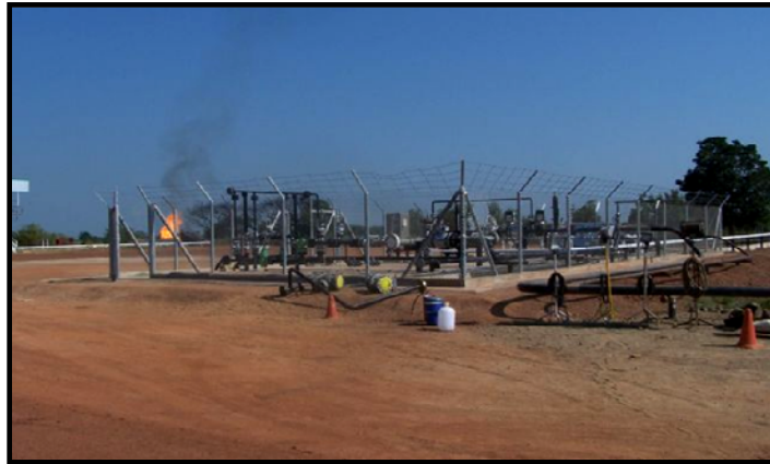
ภาพที่ 2.7-6 บริเวณสถานีควบคุมความดัน(Manifold) และ Pig launcher/receiver
