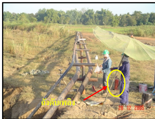
ภาพที่ 2.9-1 ตัวอย่างอุปกรณ์ป้องกันอัคคีภัยที่ติดตั้งช่วงการวางท่อลำเลียง
