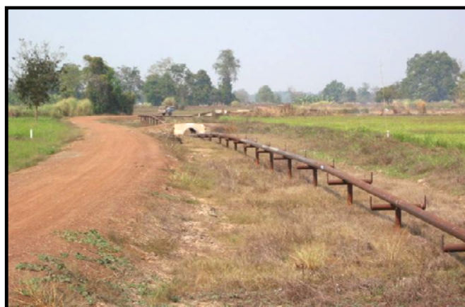
ภาพที่ 2.7-5 รูปแบบฐานวางท่อของเจ้าของโครงการ
