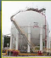
ตัวอย่างถังเก็บผลิตภัณฑ์โพรเพนทรงกลม และระบบกำจัดสิ่งเจือปนในผลิตภัณฑ์
