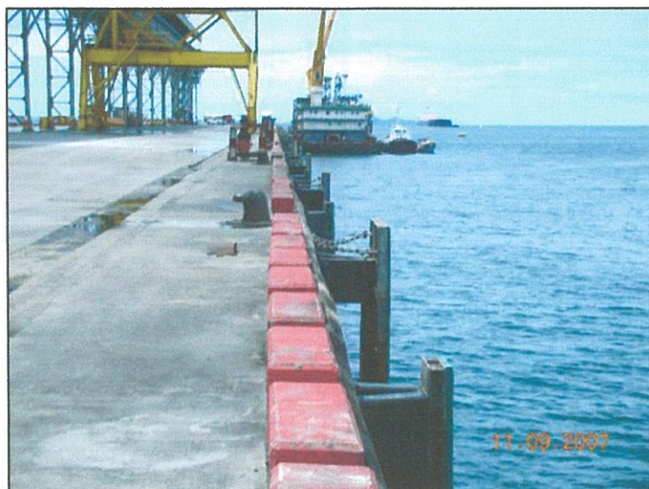
รูปที่ 2.6-1 ก. แสดงคันคอนกรีต และช่องระบายน้ำ บริเวณท่าเทียบเรือ
