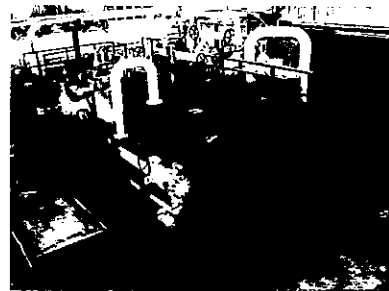
ภาพที่ 2-27 ฐานรองรับคอนกรีตเสริมเหล็ก ป้องกันแรงสั่นสะเทือน
